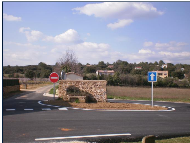
Accès au chemin de Lacré, en face l'Eglise
