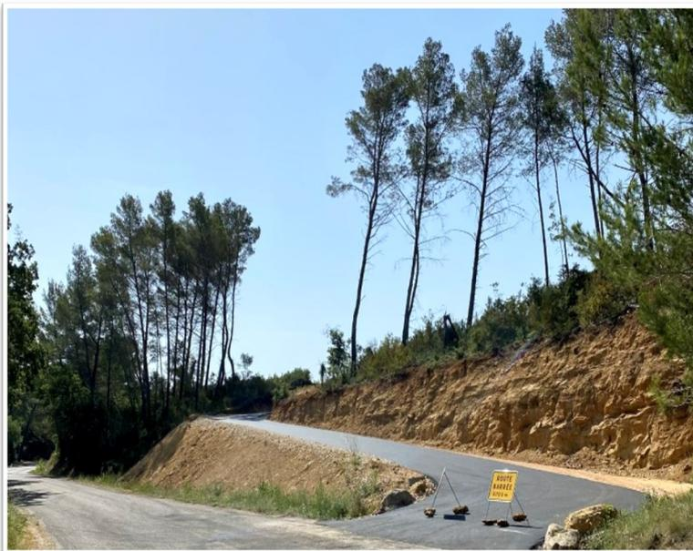
★ Les travaux « Traverse Camp des Baumes » consistent à finaliser la chaussée pour la mise en circulation en double sens. La circulation et l'accès des secours en toute sécurité seront facilités pour tous.
