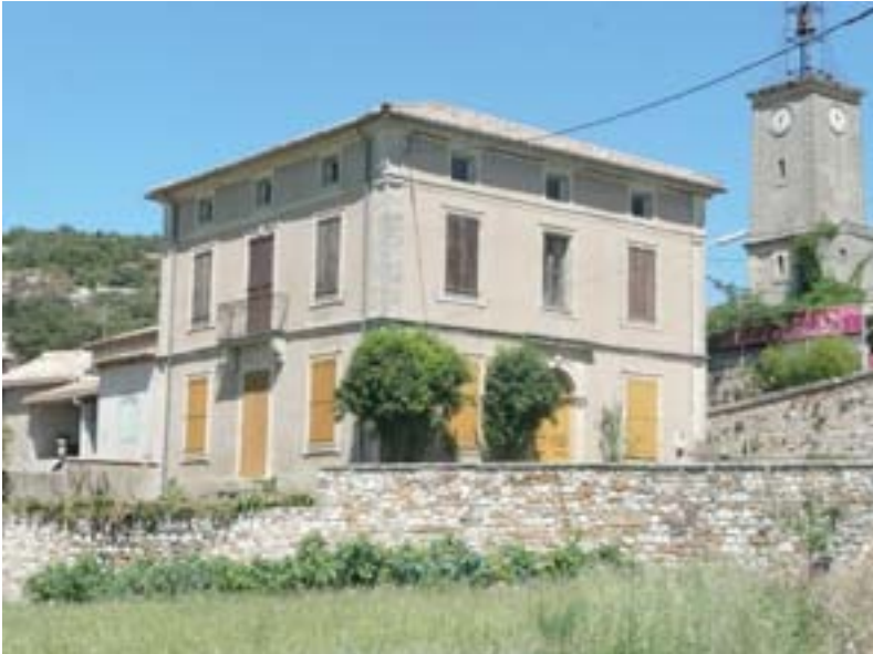
1) Vue Sud Est du Presbytère depuis le champ en contre-bas
